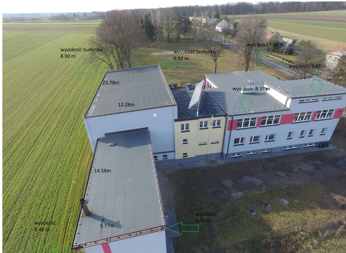
Zdjęcie 1. Stan obecny pokrycia dachowego- wymiary dachu
